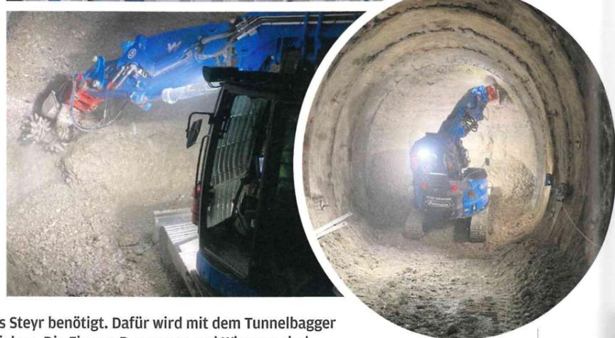
Für die Erstbefüllung des Tiefbeckens wird Wasser aus dem Fluss Steyr benötigt. Dafür wird mit dem Tunnelbagger Blue Badger der Firma Wimmer ein 120 m langer Tunnel vorgetrieben. Die Firmen Bernegger und Wimmer sind bereits seit Jahrzehnten durch eine enge Zusammenarbeit in den Bereichen Anbaugeräte und Bohrlafetten verbunden. Im Bild von links die beiden Geschäftsführer Andreas Wimmer und Kurt Bernegger.
